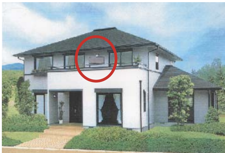
図 1.3 : 壁面設置型受信アンテナの外観
